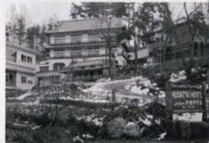
昭和27年頃の改築時の様子
